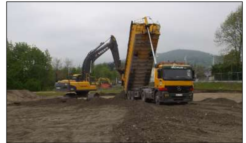
Réemploi de matériaux sous voirie
