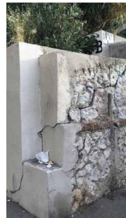
Le mur de soutènement boulevard Delpuech présente une fissure importante qui interroge sur la pérennité de l'ouvrage.
